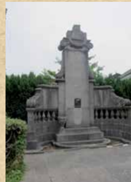
Monument aux morts à Battice érigé par les intempéries et la pollution atmosphérique.
